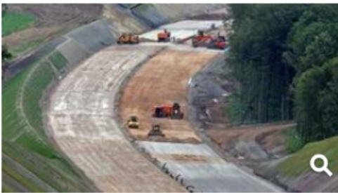
Baustelle der A4 bei Eisenach. Verdoppelung der Straßen verdoppelt den Verkehr.
